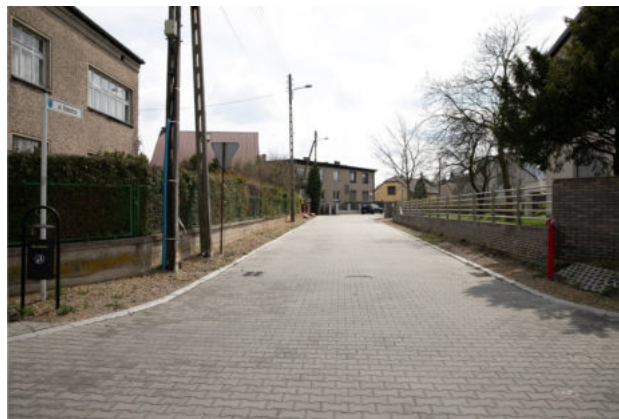
Zakończona przebudowa ulicy Staszica
