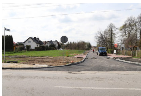
Przebudowa ulicy Hlonda
