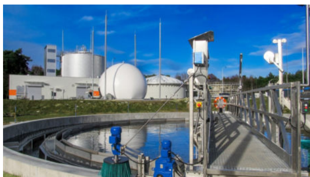
Zakończona modernizacja i rozbudowa oczyszczalni ścieków z uwzględnieniem rozbudowy części osadowej.
