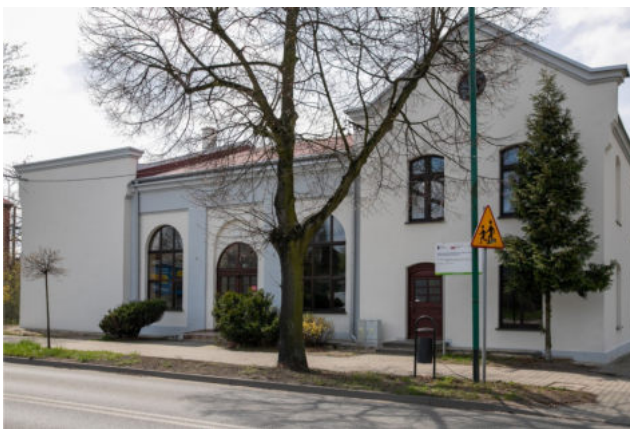
Kompleksowa termomodernizacja budynku „Halki” przy ulicy Stalmacha 12.
