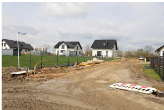
Przebudowa ulicy Hadyny
