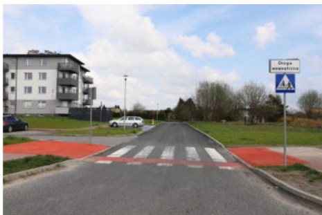
Zakończona budowa drogi wewnętrznej przy ulicy Płk. W. Wilniewczyca
