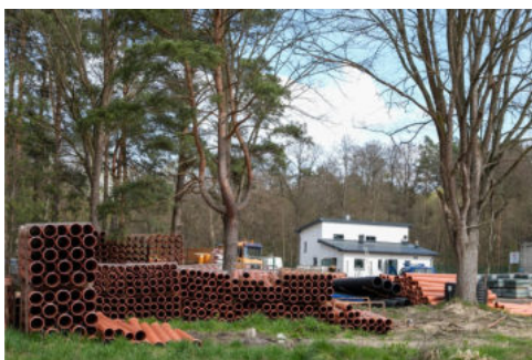
Budowa sieci kanalizacji sanitarnej wraz z oczyszczalnią ścieków w Kokotku.
