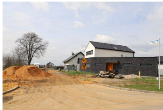
Przebudowa ulicy Kilara
