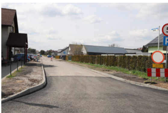
Przebudowa ulicy Cebuli
