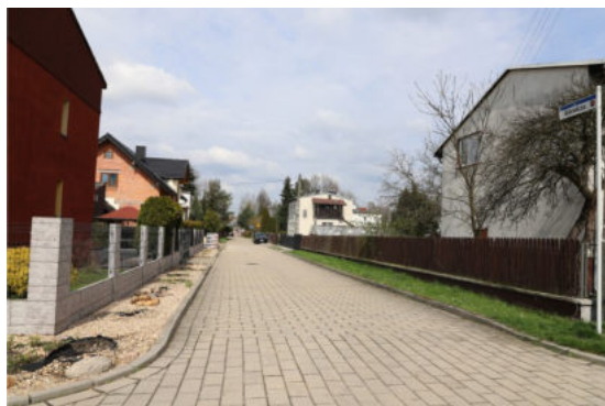
Przebudowa ulicy Górniczej
