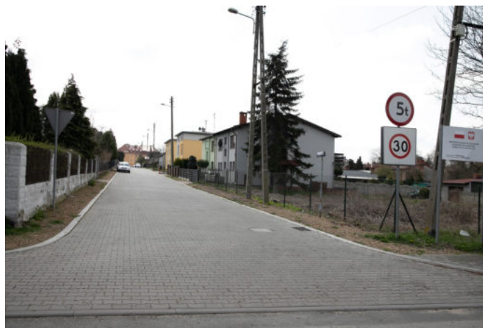
Zakończona przebudowa ulicy Ligonia
